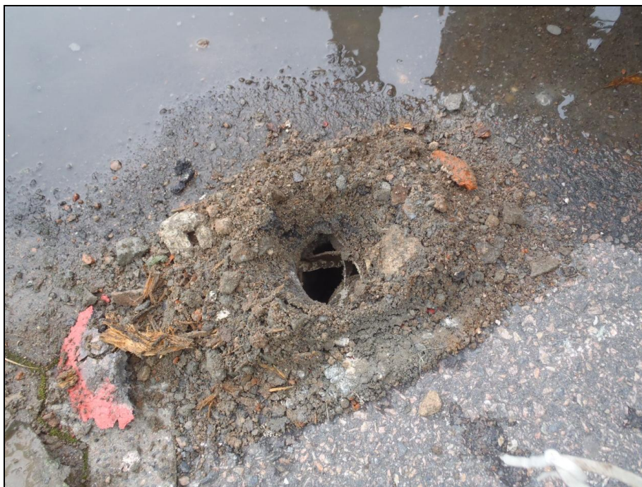
Bild 5 Inslag av tegel betong och trä vid provpunkt 35
